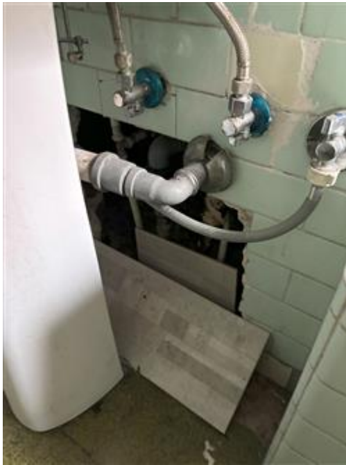
Intervento per la creazione del nuovo attacco lavello per la cucina, collegato all'impianto esistente.
