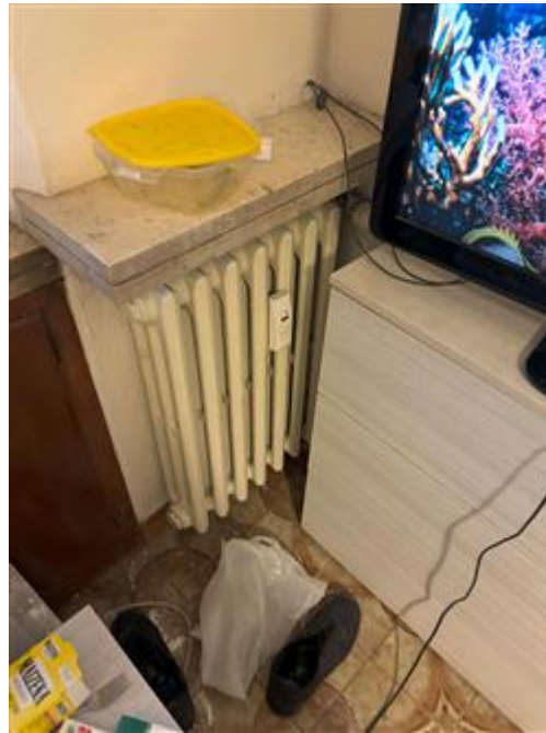
Impianto di riscaldamento centralizzato, dotato di termovalvole e contabilizzatori di calore indiretti.
